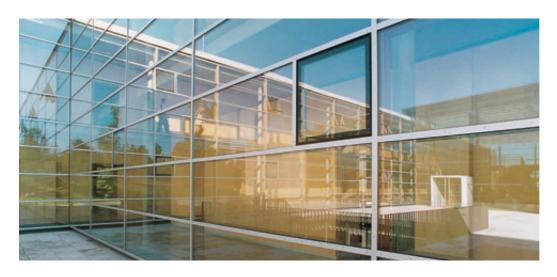
SANCO PLUS® nützt die Sonne als zusätzliche Heizquelle Energiesparen mit SANCO PLUS bedeutet nicht nur ein 'Einsperren der Raumwärme' durch das Wärmedämmglas, es bedeutet zusätzlich den Wärmezugewinn durch die einfallenden Sonnenstrahlen. Durch den positiven Wärmegewinn spricht man auch von einer 'Wärmefalle', denn die Raumwärme bleibt praktisch voll
